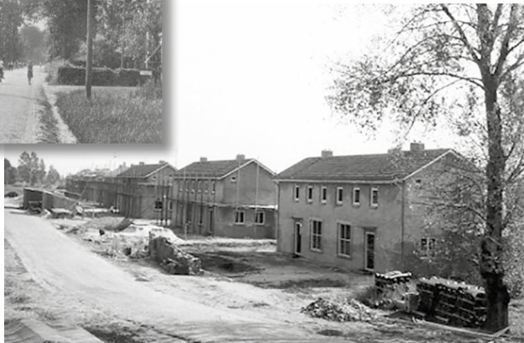
Onder: De Mente in aanbouw
