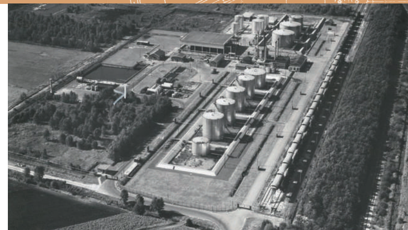
Het ROV (Ruwe Olie Verlaadstation) aan de Kanaalweg
